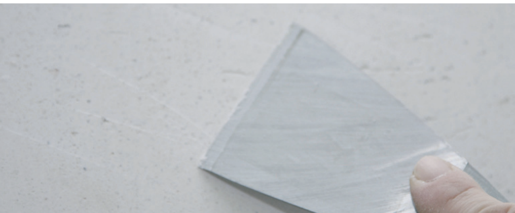
Retapando pequeños agujeros y fisuras sin movimiento con espátula estrecha (6 – 8 cm) sobre fondos de yeso
